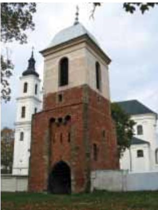
Brama wjazdowa – pozostałość obwarowań obronnych klasztoru w Witowie
