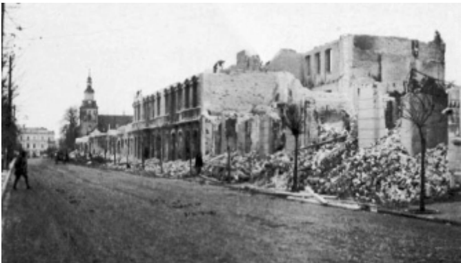
„Krzywda” – zburzone kamienice na ulicy Słowackiego po nalocie Luftwaffe
