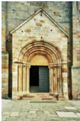
Portal kościoła p.w. św. Tomasza Kantuaryjskiego w Sulejowie – Podklasztorzu
