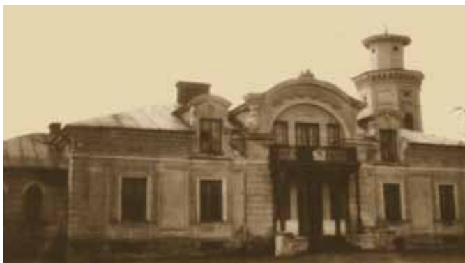
Pałacyk Psarskich, rozebrany przy budowie ronda u zbiegu ulic Sulejowskiej i Śląskiej
